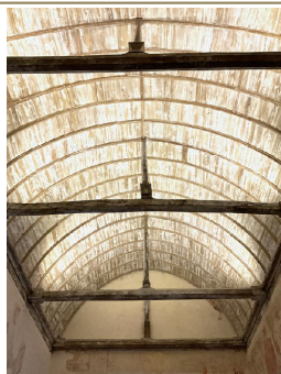
Nef, charpente de couverture vue depuis l'ouest
