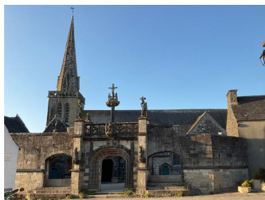
Vue générale depuis le sud
