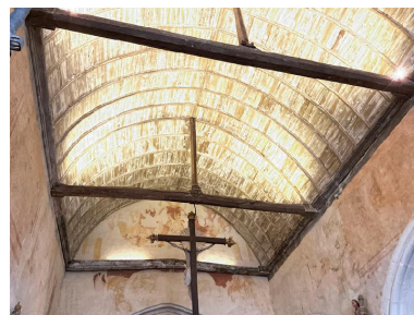
Choeur, charpente de couverture vue depuis l'est
