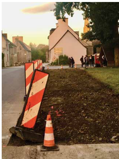
Chantier Quais de bus
